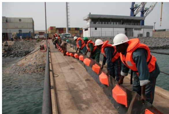
Démonstration par la SHELL
