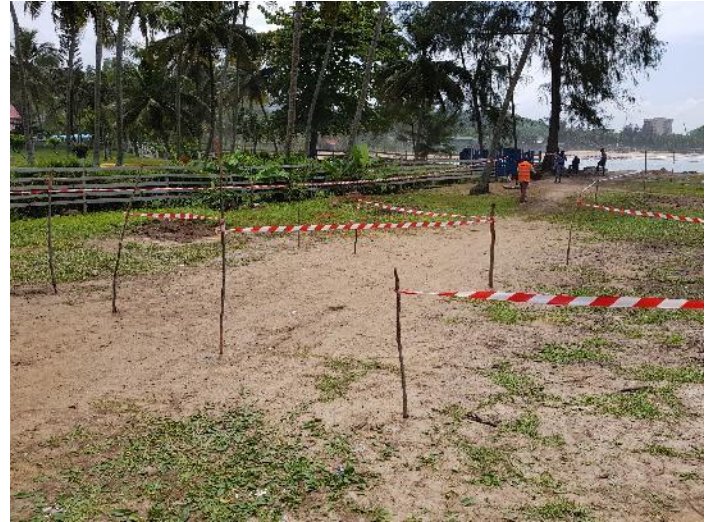
Circulation et sécurisation du site
