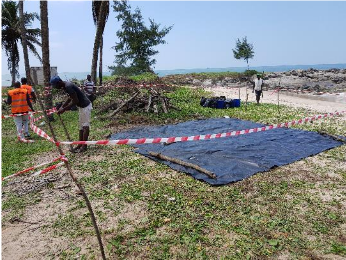
Zone de stockage des déchets
